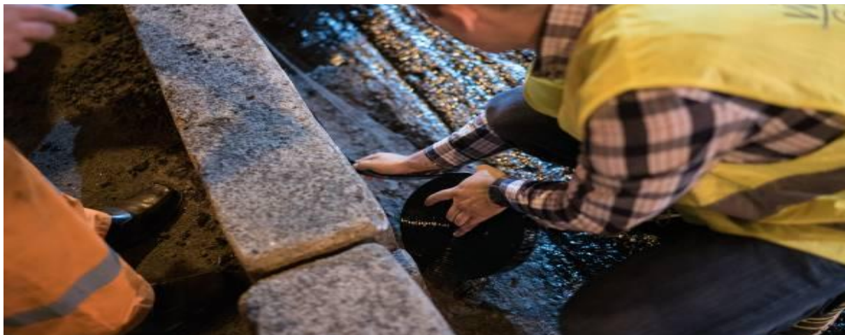
Устройство сопряжения асфальтобетонного покрытия с бордюрным камнем с применением стыковочной ленты
