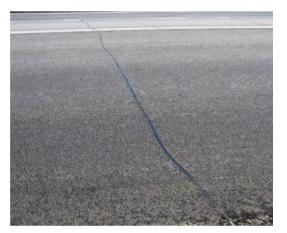
Современные технологии строительства позволяют существенно снизить динамику трещинообразования асфальтобетонных покрытий, однако не в состоянии обеспечить полное отсутствие трещин
