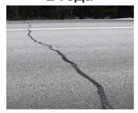
Герметизация битумнополимерными мастиками
