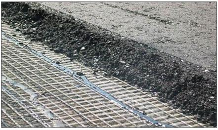
Отраженные трещины характерны для покрытий, устраиваемых на жестких или трещиноватых основаниях. Применение геосеток позволяет замедлить их развитие, однако технологии, обеспечивающие полное отсутствие отраженных трещин в настоящее время отсутствуют
