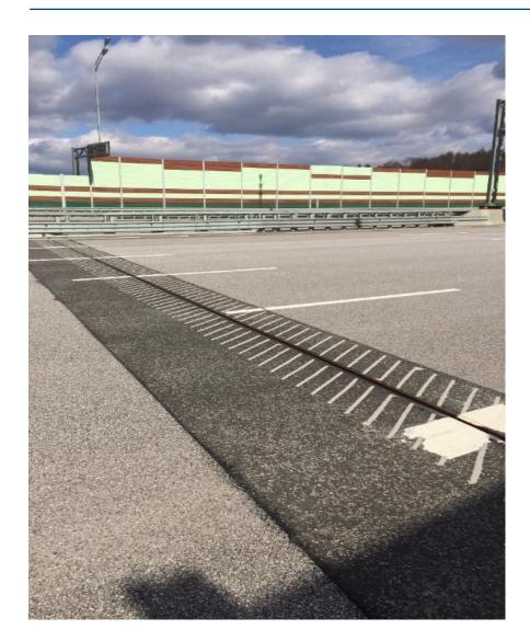
После 2-3 лет эксплуатации в узлах, где было предусмотрено применение лент, дефекты отсутствуют, а на стыках, устроенных без лент, образовались трещины на всю ширину проезжей части
