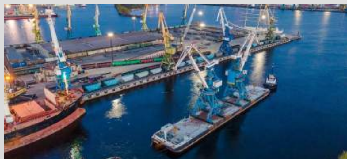
ЛЕНИНГРАДСКАЯ ОБЛАСТЬ Развитие железнодорожного узла у морского торгового порта Усть-Луга
