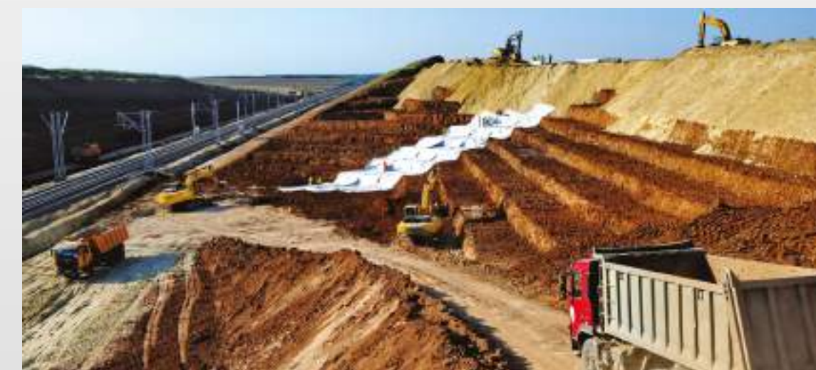
ВОРОНЕЖСКАЯ ОБЛАСТЬ Строительство двухпутной железной дороги на участке Журавка—Миллерово
