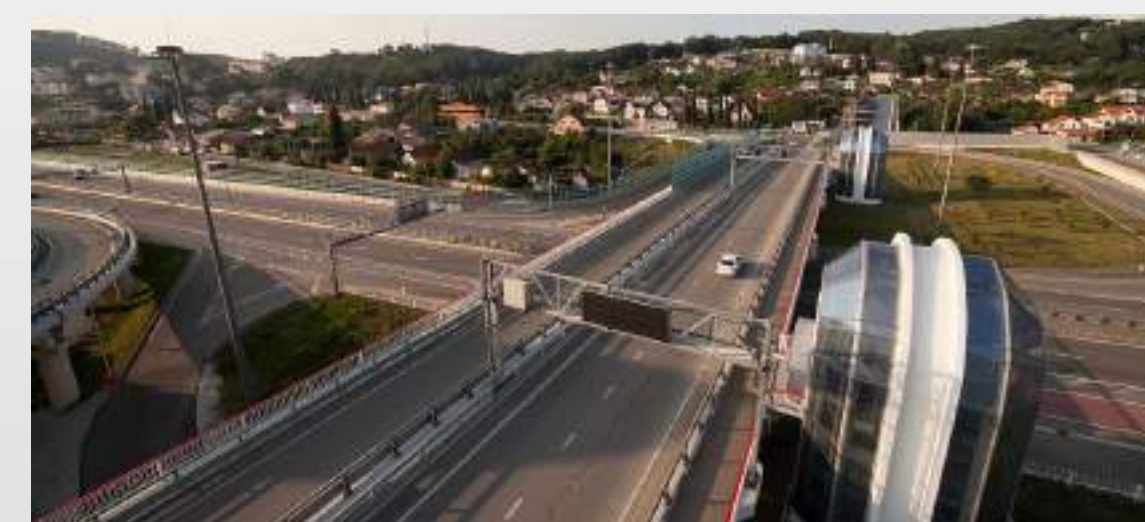
А147 «СОЧИ — ДЖУБГА» Федеральная трасса (участок длиной 5,3 км)
