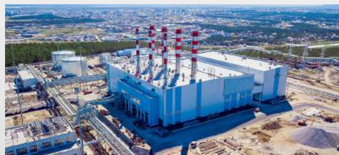
РЕСПУБЛИКА САХА (ЯКУТИЯ). ЯКУТСКАЯ ГРЭС-2
