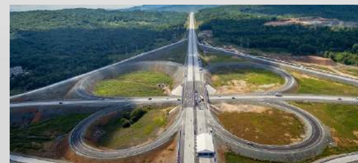
ВЛАДИВОСТОК. АВТОДОРОГА «ВЛАДИВОСТОК — НАХОДКА — ПОРТ ВОСТОЧНЫЙ» (участок длиной 43 км)
