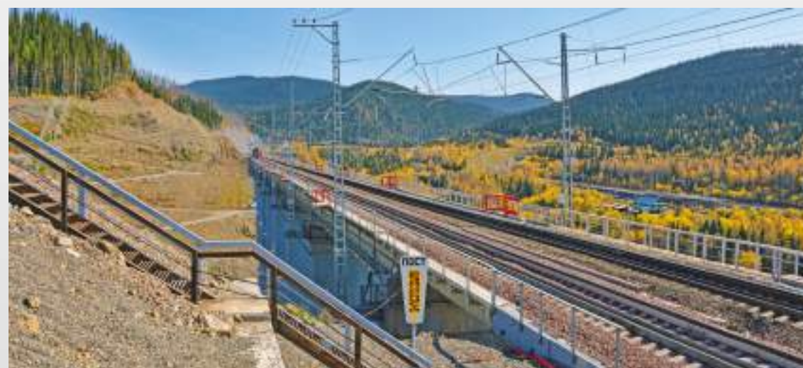
КРАСНОЯРСКИЙ КРАЙ, ЮЖНО-СИБИРСКАЯ МАГИСТРАЛЬ Реконструкция Козинского виадука
