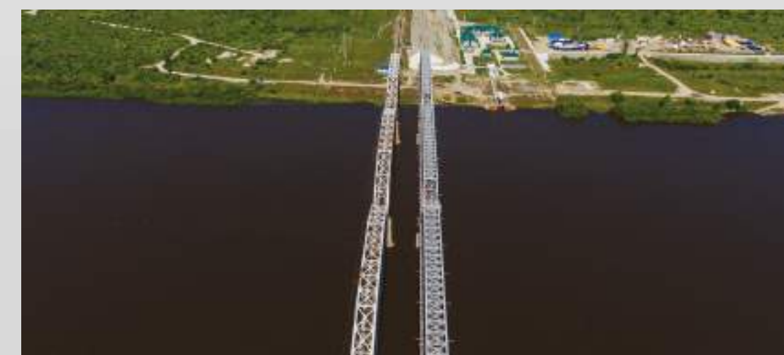
ЗАБАЙКАЛЬСКИЙ КРАЙ Мост через Зею. Модернизация Восточного полигона железных дорог России
