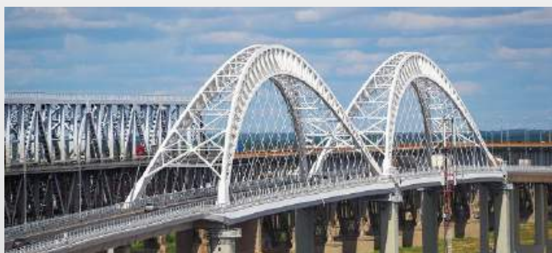
НИЖНИЙ НОВГОРОД Дублер Борского моста через Волгу [1,5 км]
