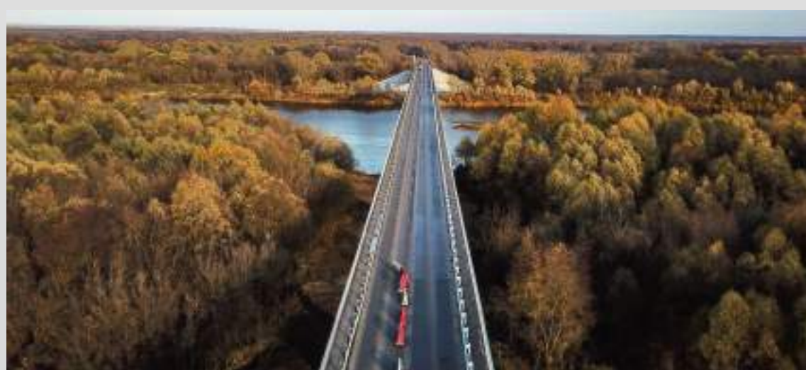
ЧУВАШСКАЯ РЕСПУБЛИКА Мост через Суру [1,2 км]
