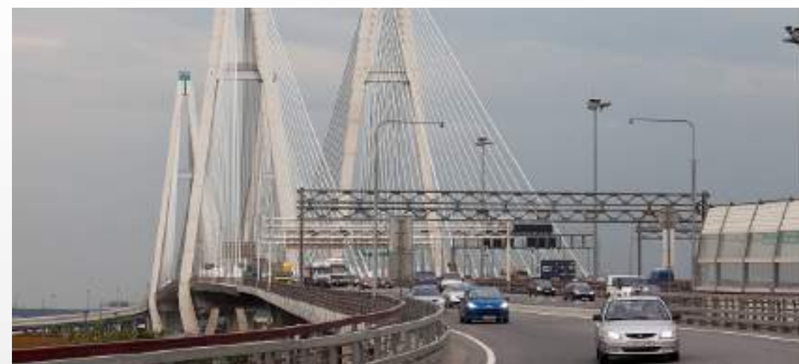
САНКТ-ПЕТЕРБУРГ Большой Обуховский мост через Неву [2,6 км]
