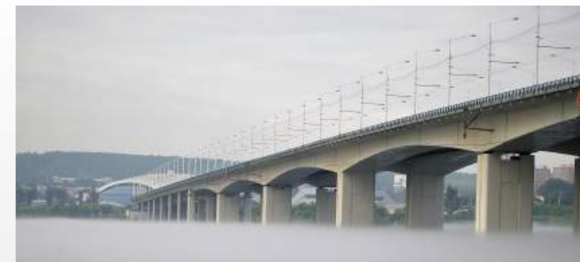
ИРКУТСК Академический мост через Ангару [1,6 км]
