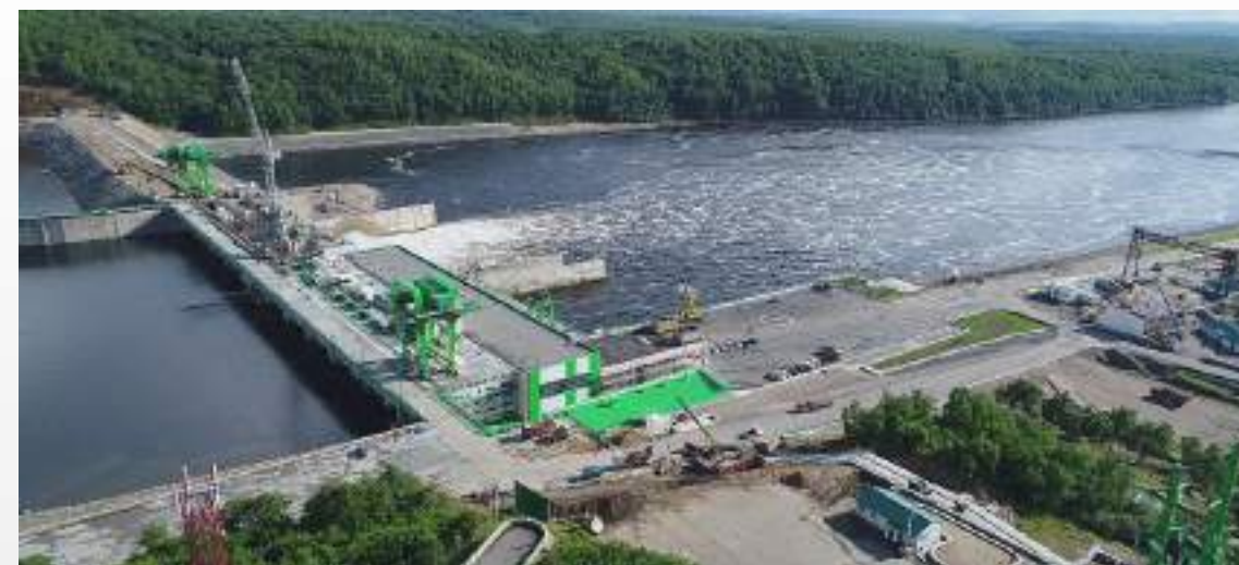
АМУРСКАЯ ОБЛАСТЬ. НИЖНЕ-БУРЕЙСКАЯ ГЭС
