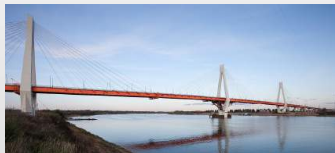
МУРОМ Мост через Оку [1,4 км]
