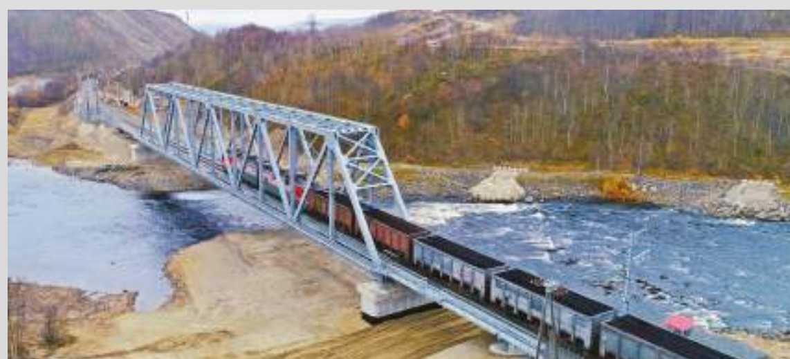
МУРМАНСКАЯ ОБЛАСТЬ Строительство нового железнодорожного моста через Колу
