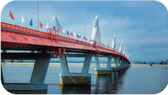
Пограничный мостовой переход через р. Амур
