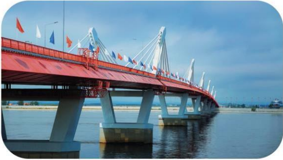
Пограничный мостовой переход через р. Амур
