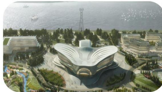
Терминальная станция трансграничной канатной дороги КНР
