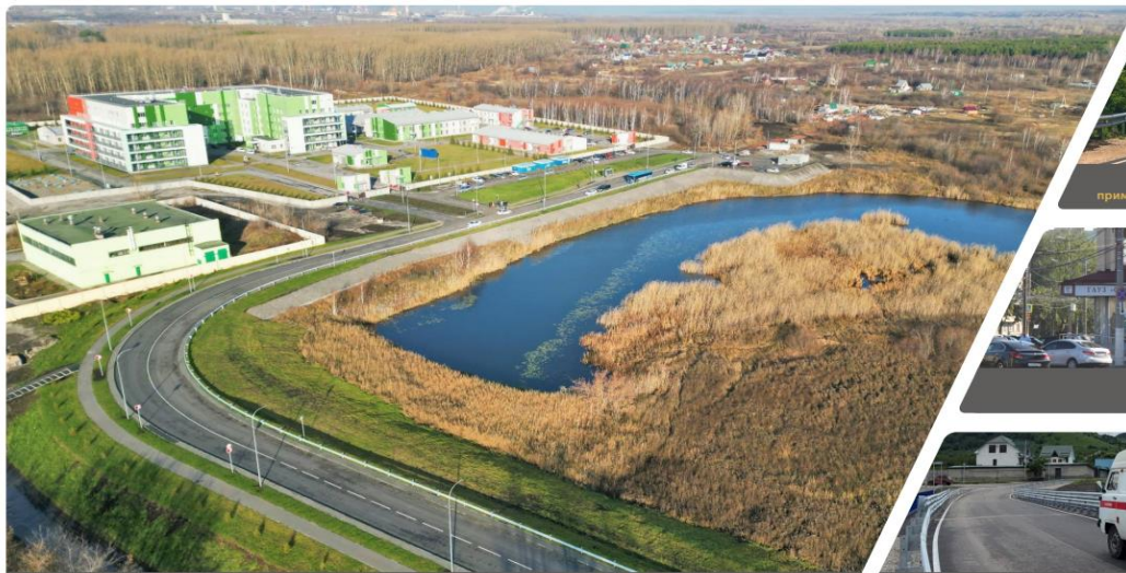
Жемеровская область – Кузбасс, Новокузнецк, а/д от Пойменского шоссе к Новокузнецкой инфекционной больнице № 8
