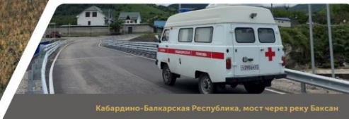
Кабардино-Балкарская Республика, мост через реку Баксан
